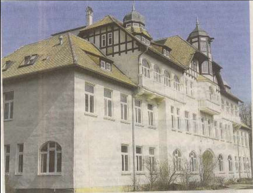
Zunächst soll nur das Erdgeschoss der ehemaligen Klinik für den Schulbetrieb genutzt werden. FOTO: THOMAS KREJCIK
