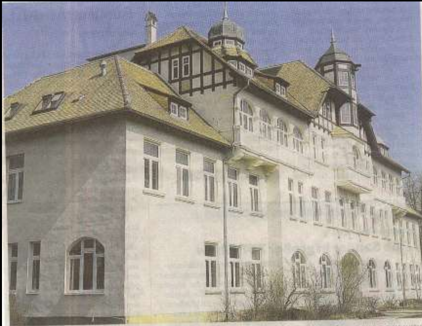
Zunächst soll nur das Erdgeschoss der ehemaligen Klinik für den Schulbetrieb genutzt werden. FOTIEF THOMAS REISCH
